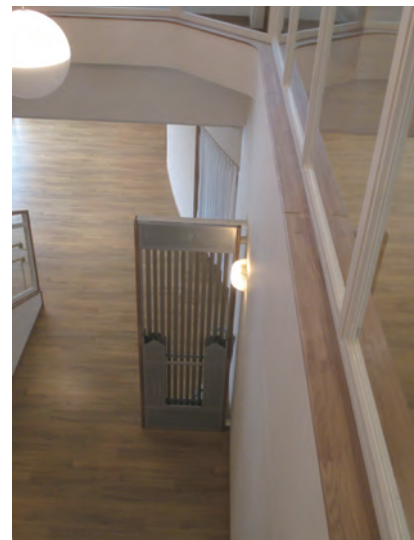
廊下の設置状況
